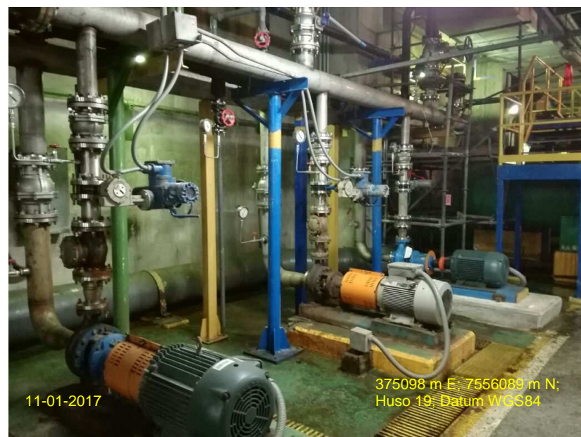
Foto 2: tie-in's en el circuito agua de mar NT01
