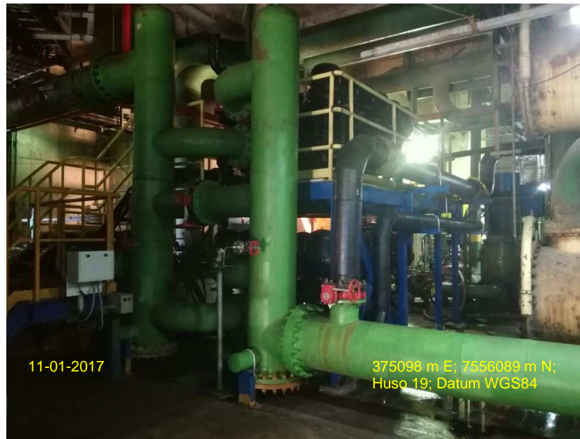
Foto 1: tie-in's en el circuito agua de mar NT01
